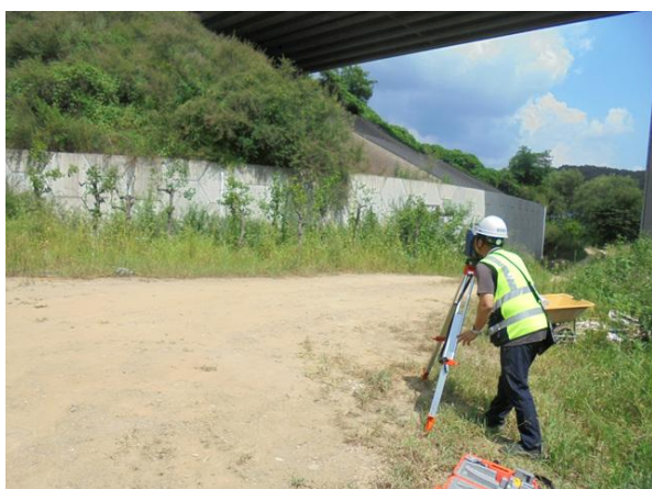
광파기를 이용한 측량 작업
